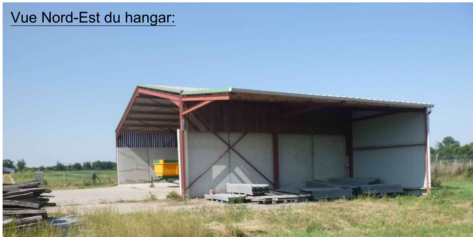
Vue Nord-Est du hangar:
